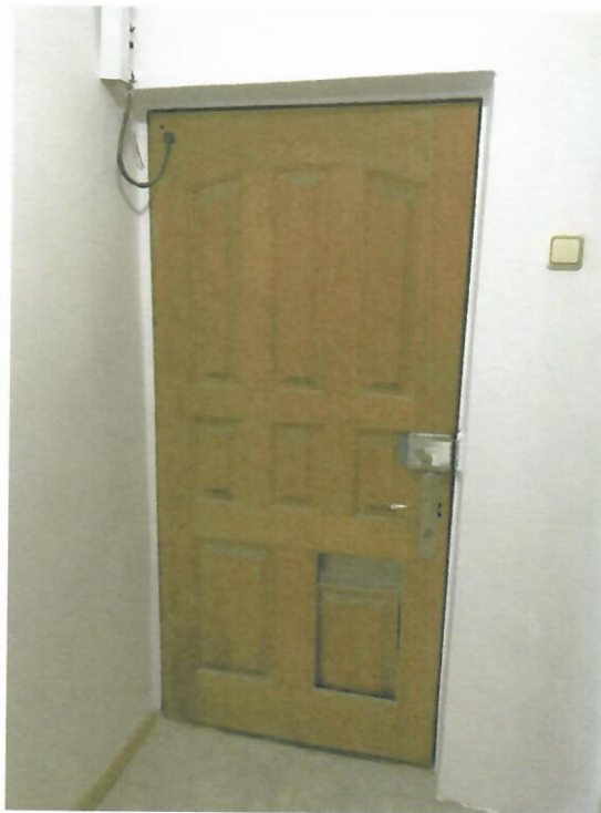
Фото 4 Входная дверь из здания в коридор офиса
