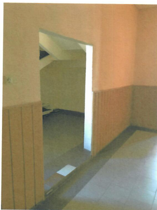
Фото 2 Проход к лестничной клетке
